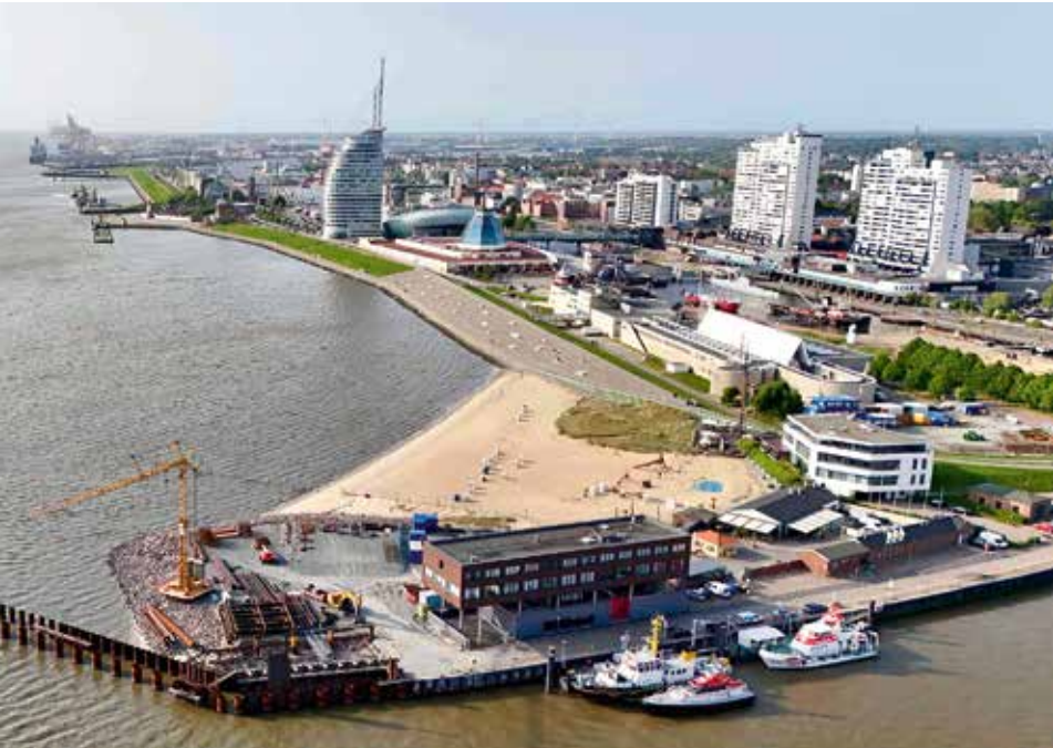
Der Neubau der Nordmole in Bremerhaven läuft auf Hochtouren. Das neue Bauwerk wird 280 Meter lang und erhält den historischen Leuchtturm als Wahrzeichen zurück.
