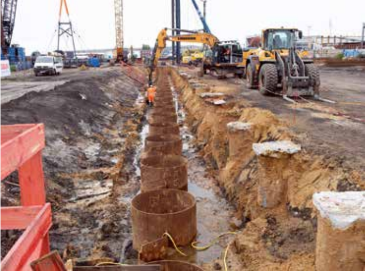
Mit der Sanierung der Westkaje wird in Bremerhaven mehr Platz für den Bau von Konverterplattformen für Offshore-Windenergie geschaffen, ebenso für Wendemanöver großer Schiffe.
