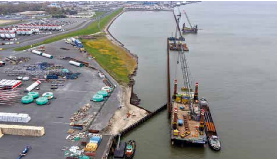
Bis 2028 entstehen in Cuxhaven im Zuge des Ausbaus des Offshore-Hafens drei neue Schwerlastliegeplätze.
