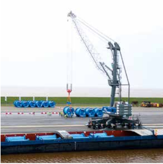
Das Know-how und die Technik für den Umschlag von Kabeltrommeln am Emden Südhafen ist bei Epas vorhanden, allerdings nicht genügend Kapazität. Künftig werden für Großprojekte Flächen in Dörpen genutzt.
