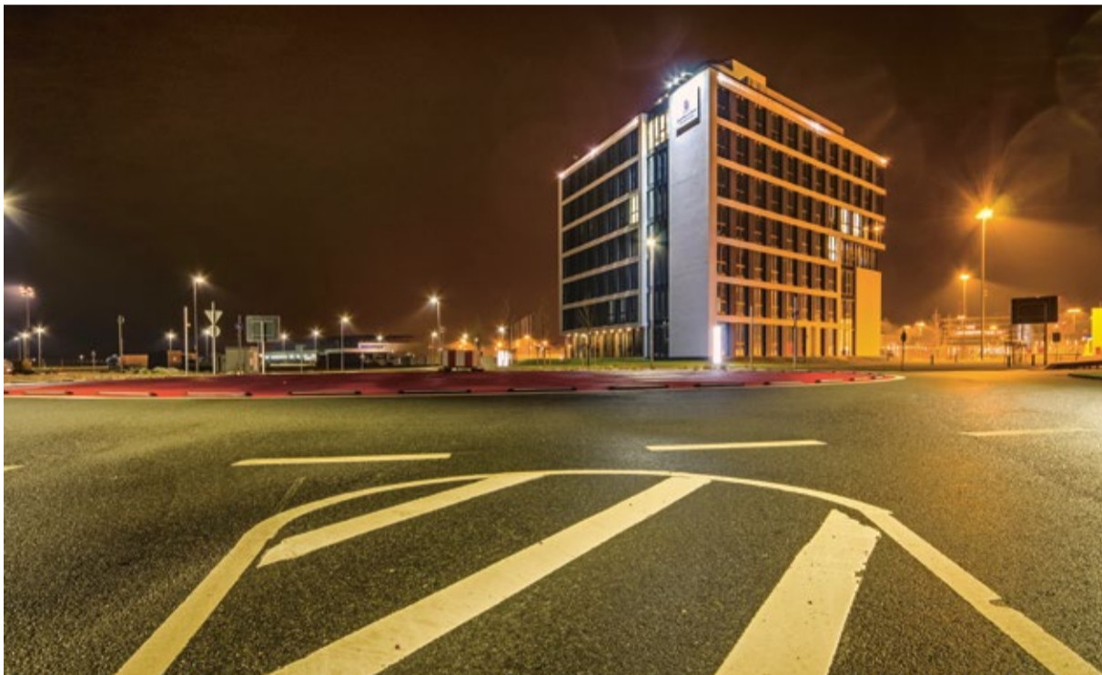
Vom Bürogebäude „Pacific One“ aus ermöglicht der Fashion-Logistiker seinen Kunden, von den Vorteilen des JadeWeserPorts zu profitieren. FOTO: GENIUSSTRAND.DE
