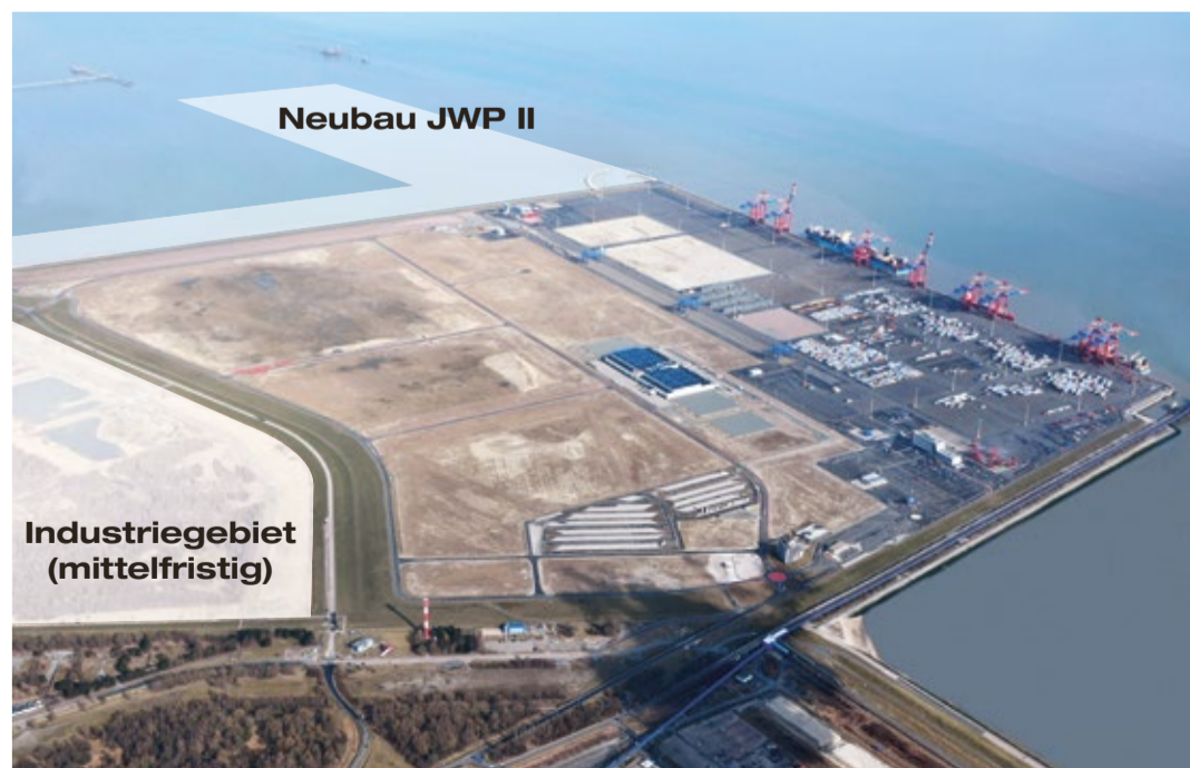
Für das zweite Containerterminal ist eine Verlängerung der Kaje um 1,8 Kilometer nach Norden möglich.
