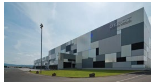
Herzstück der Depot-Logistik: das Verteilzentrum in Niedernberg bei Aschaffenburg. FOTO: GRIES DECO
