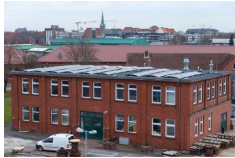
PV-Anlagen, Werkstattgebäude Emden
