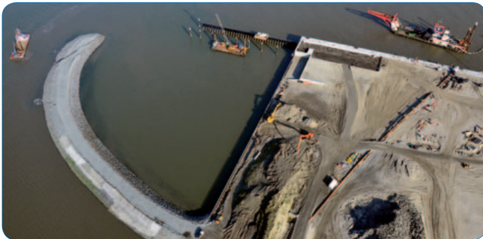
Schlepperhafen: Im Schutz der sichelförmigen Mole entstehen neun Liegeplätze.
