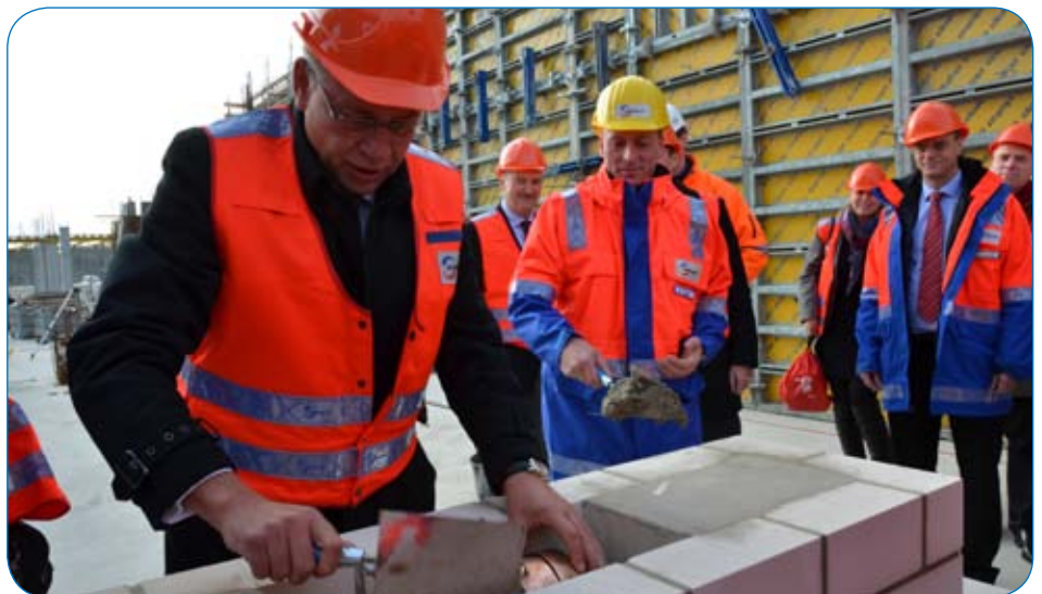
Selbst ist der Mann: Emanuel Schiffer, Vorsitzender der Eurogate-Gruppengeschäftsführung, mauert die Zeitkapsel in den Grundstein des neuen Betriebsgebäudes.
